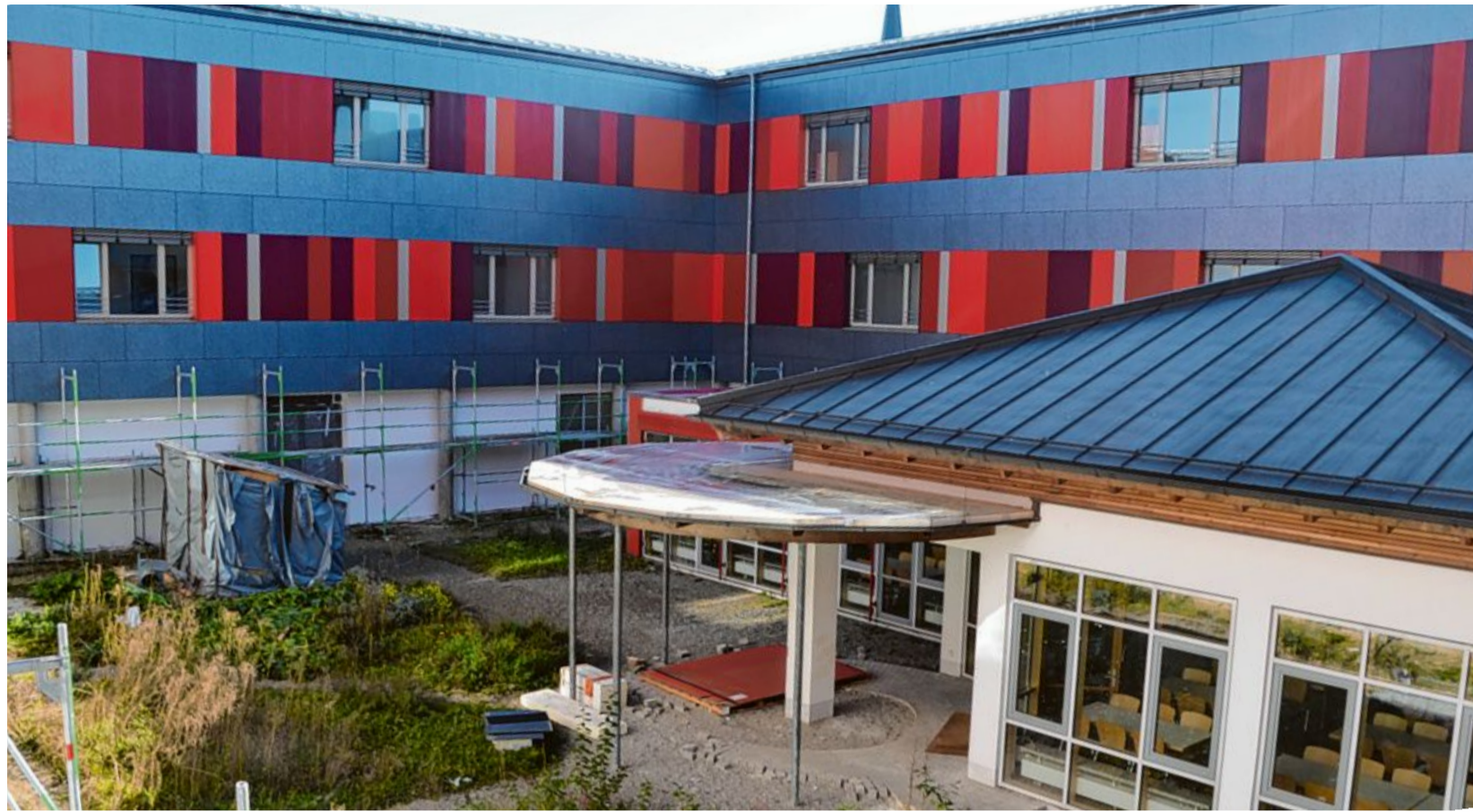
Das Johann-Michael-Sailer-Gymnasium in Dillingen wird generalsaniert. Bauabschnitt eins, an der Ziegel- und der Bürgermeister-Degen-Straße gelegen, soll im Frühjahr 2018 fertig sein. Er ist ganz in Dunkelgrau und Rot gehalten und kostet etwa 17 Millionen Euro. Im Hintergrund die Spitze der Katharinenkirche. Fotos: Homann
